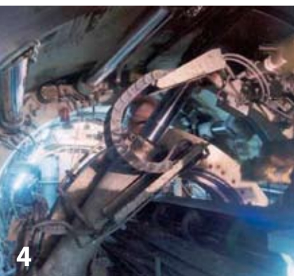
4 Konzentrierte Lasteinleitung durch TBM Concentrated load caused by a TBM
