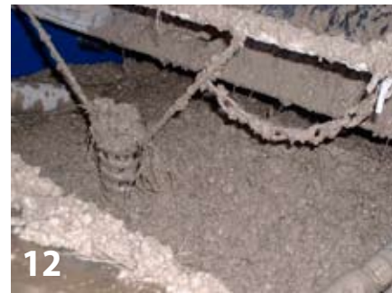
Hofoldinginger Stollen: Verarbeitung des Stahlfaserbetons mit 40 kg/m 3 Dramix RC-65/60-BN
