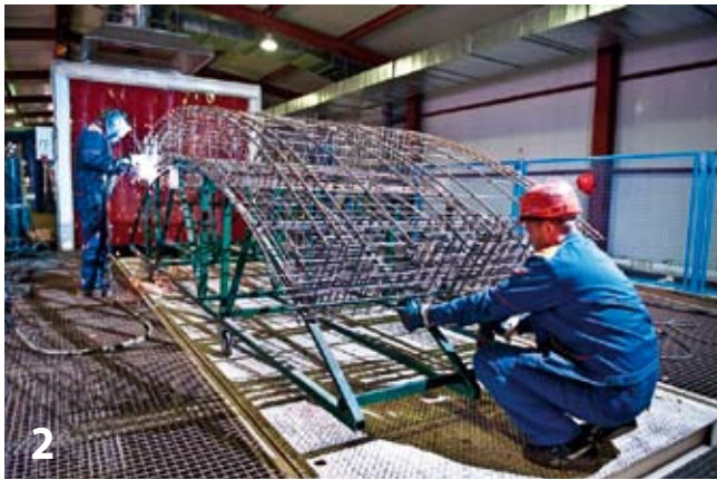
2 Typische Bewehrungsarbeiten bei herkömmlich bewehrten Tübbingen Typical reinforcement work for conventionally reinforced lining segments
