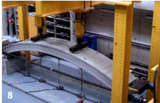
Belastungstest an einem Einzelsegment Load test on an individual segment
