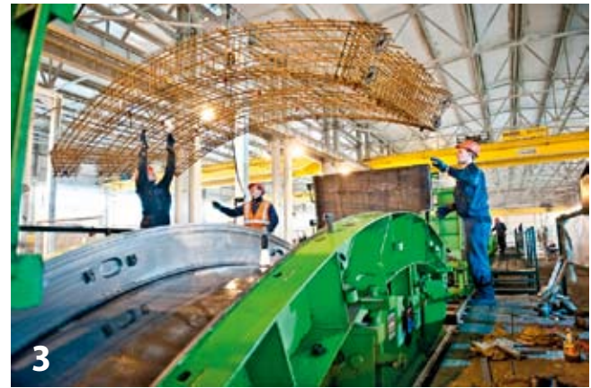
3 Typische Verlegearbeiten bei herkömmlich bewehrten Tübbingen Typical installation work using conventionally reinforced lining segments
