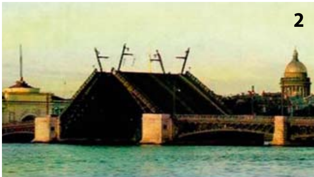
Geöffnete Klappbrücke über die Neva Open Balance Bridge in St. Petersburg
