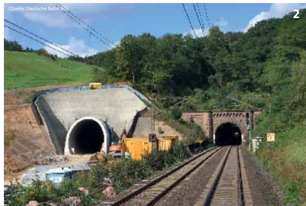
Bau des neuen Bebenroth-Tunnels zwischen Werleshausen und Eichenberg auf der Nord-Süd-Strecke Building the new Bebenroth Tunnel between Werleshausen and Eichenberg on the north-south route
